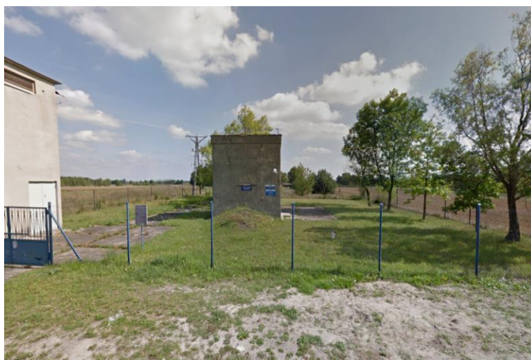
Budynek ujęcia wód podziemnych Źródło: http://google.pl/maps
